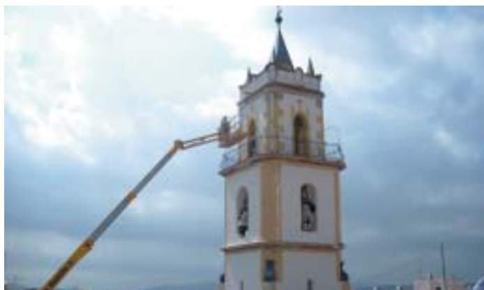
LOS PINTORES ACCEDIERON A LA PARTE ALTA DE LA TORRE CON ESTA GRÚA DE GRANDES DIMENSIONES
